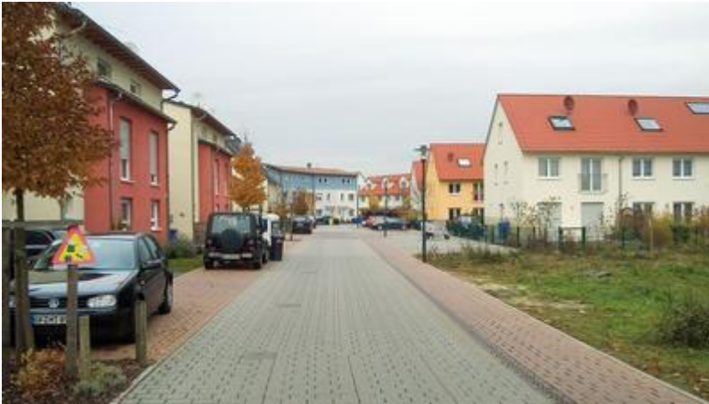
Abb. 5: Das Neubaugebiet im Ortsteil Mainflingen wird über ein Nahwärmenetz mit Heizenergie versorgt
