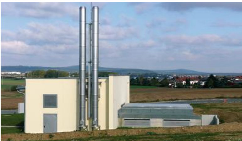
Abb. 6: Heizhaus mit der Holzhackschnitzel-Heizanlage im Gewerbegebiet Am Kellerborn
